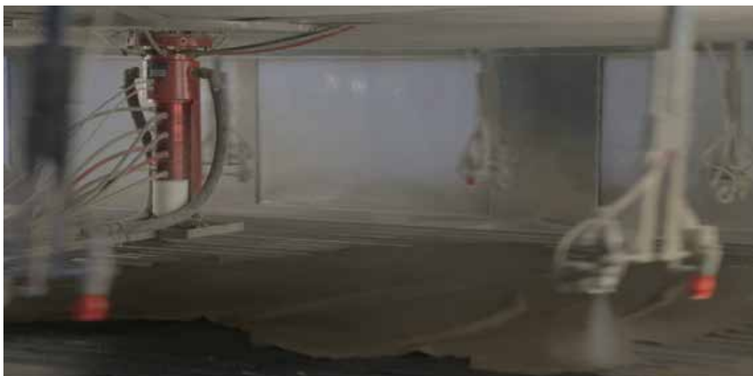
Konečná úprava pomocí spreje
